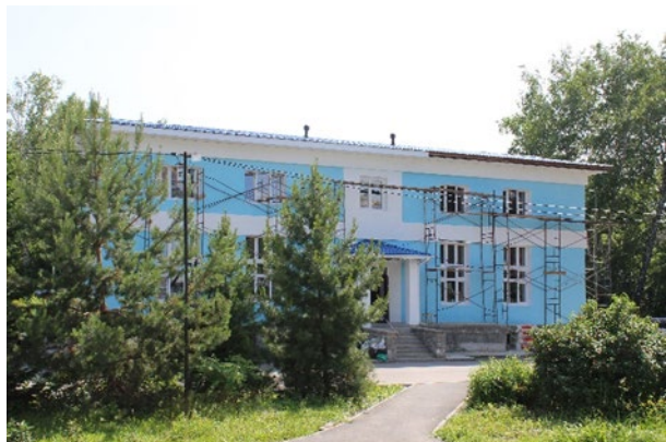
Заканчивается строительство приходского дома рядом с храмом. 2025 год
